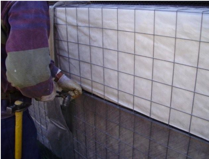
Fissaggio moduli di base DRENTER 1.000 con moduli DRENTER 500
