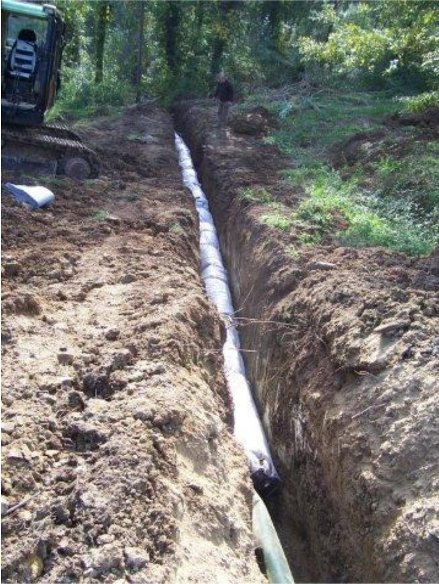
Figura 10-Posa in trincea della cordata di IDROSAC per il primo filare
