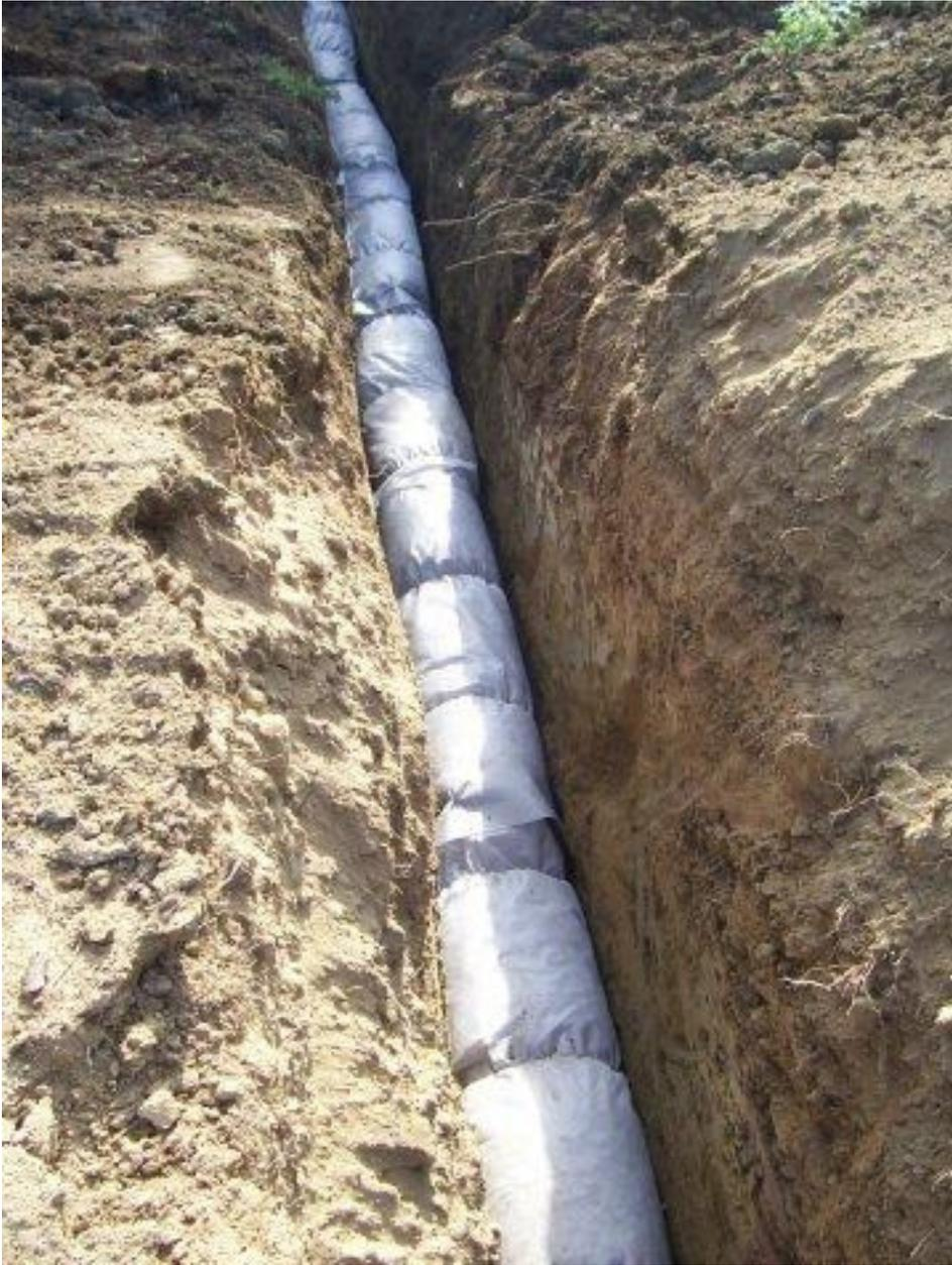
Figura 12-Posa in trincea dei sacchi per il secondo filare
