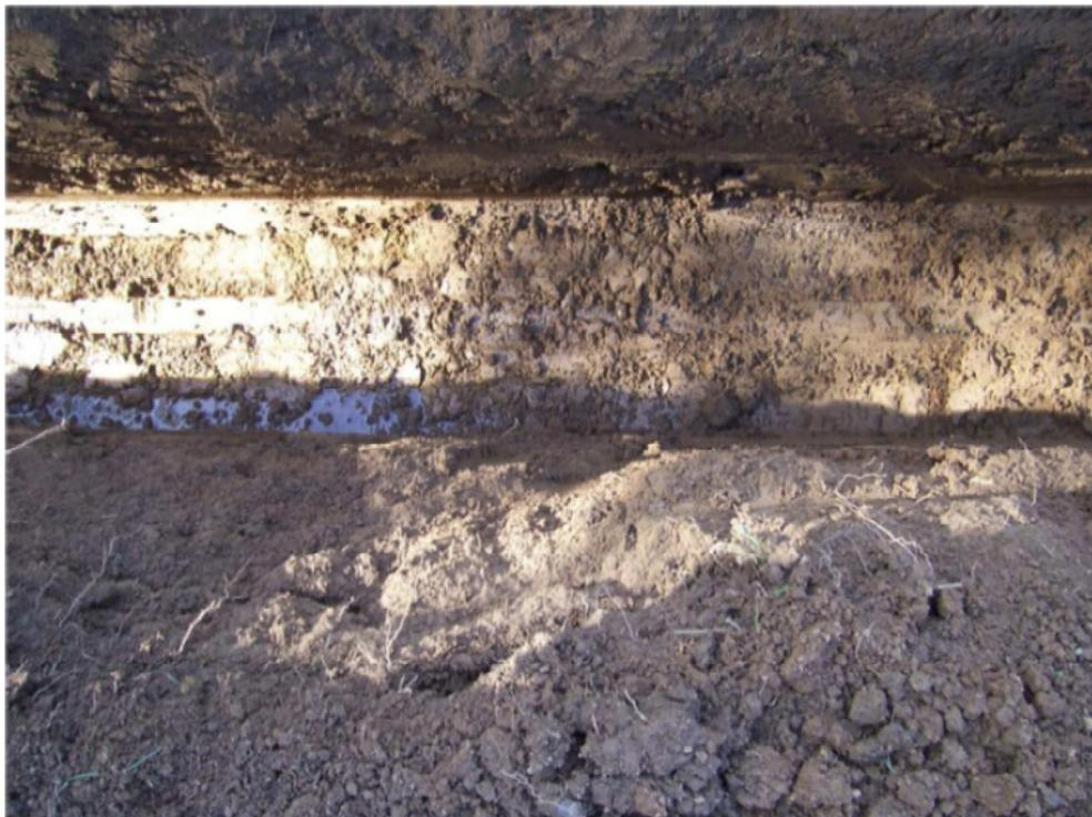
Figura 5 – Presenza di acqua sul fondo della trincea.
