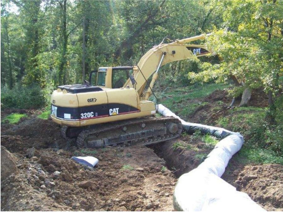
Fig.8-Sistema dei moduli IDROSAC montato a regola d'arte lungo la trincea del primo dreno
