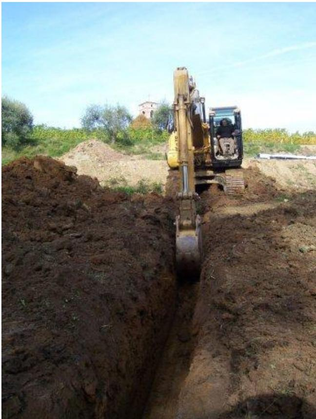
Figura 6-scavo di sbancamento effettuato con escavatore meccanico per la posa in opera del sistema IDROSAC
