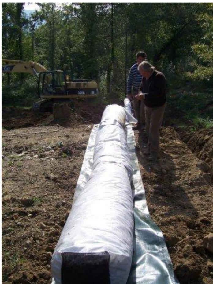
Figura 7-Stesa della guaina e dei materassi lungo la trincea per il primo dreno
