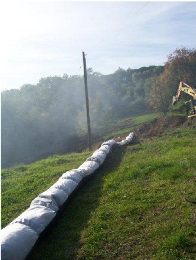
Fig.9-Sistema dei moduli IDROSAC montato a regola d'arte lungo la trincea del secondo dreno
