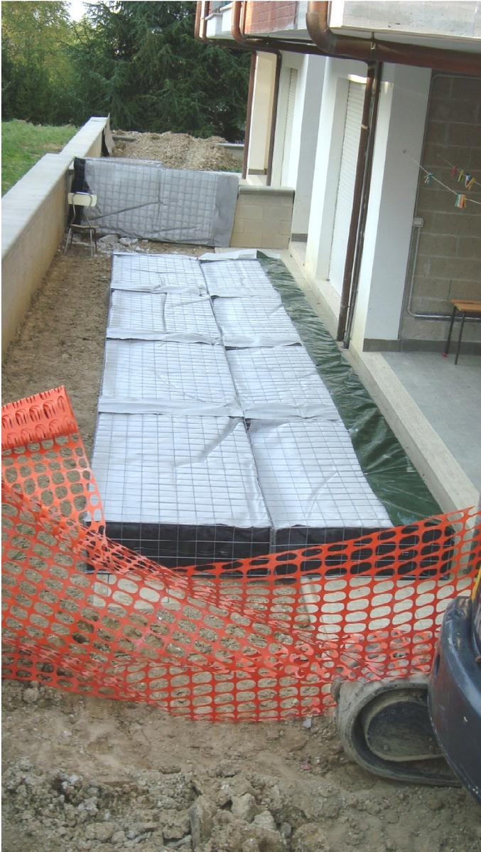
I moduli drenanti DRENTER vengono assemblati fuori scavo e impermeabilizzati sul fondo con guaina impermeabile verde
