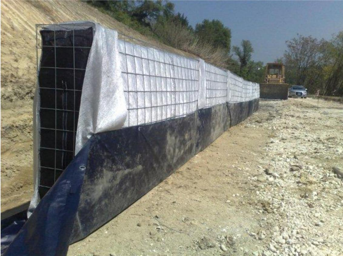
Fig.4-Sistema dei moduli DRENOTER montato a regola d'arte lungo la trincea del primo dreno
