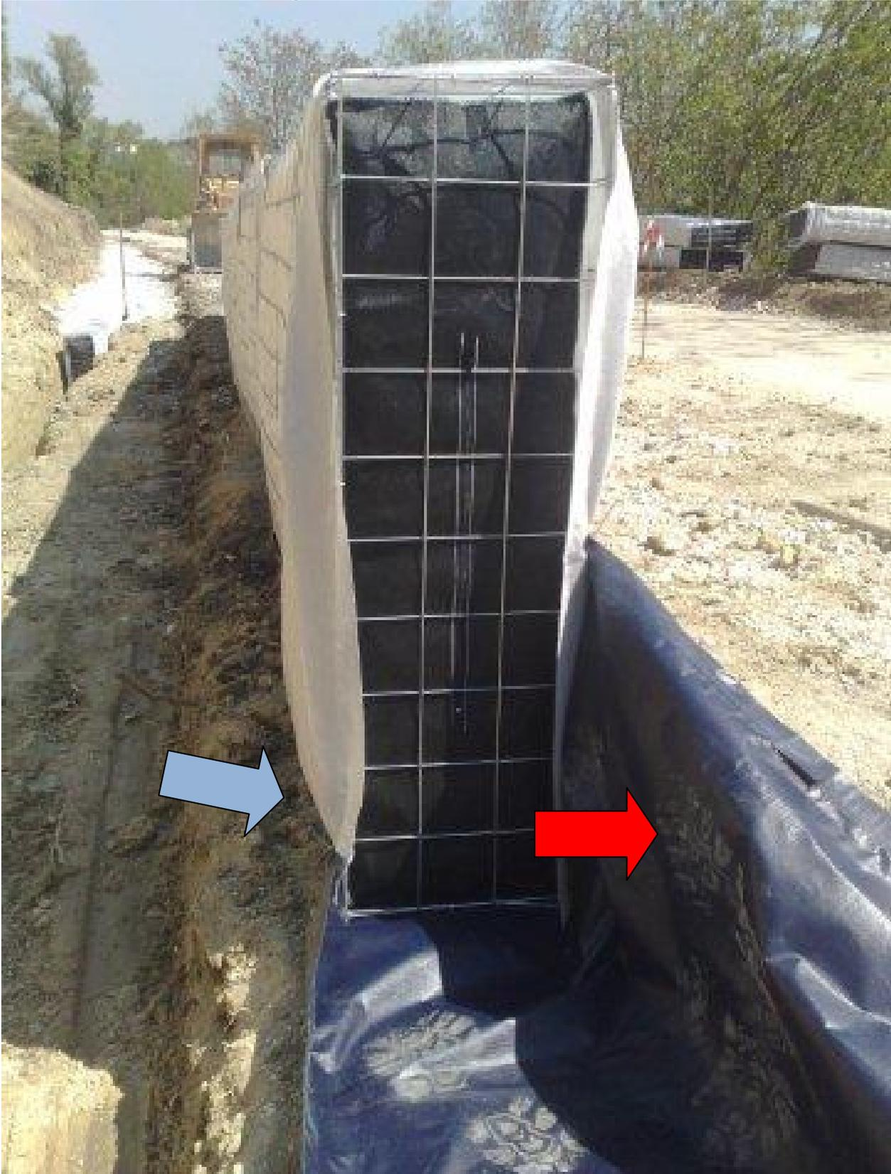
Figura 3-Stesa della guaina e dei materassi lungo la trincea per il dreno, si nota la guaina posizionata a L, con la parte ribassata verso monte per migliore captazione acque (freccia celeste) ed effetto barriera nel lato di valle (freccia rossa).
