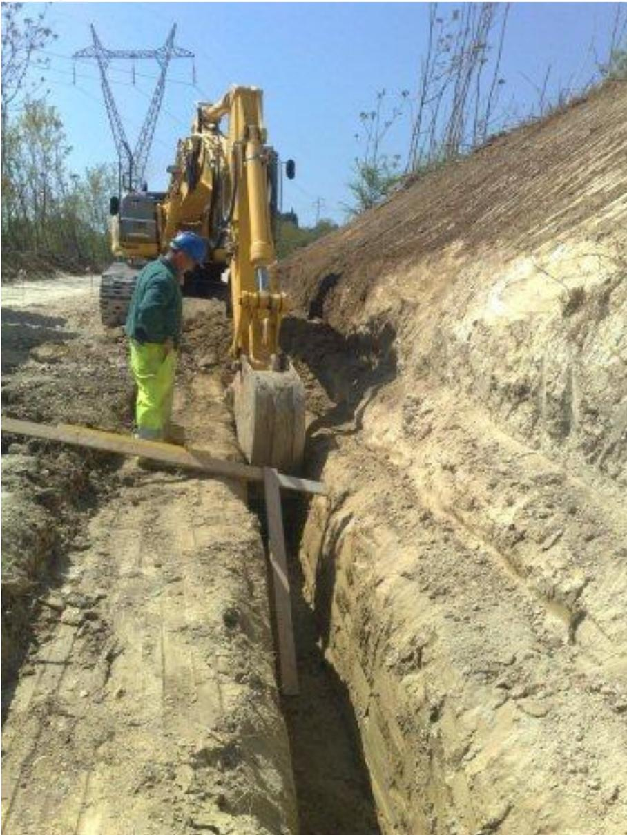
Figura 2-scavo di sbancamento effettuato con escavatore meccanico per la posa in opera del sistema DRENTER
