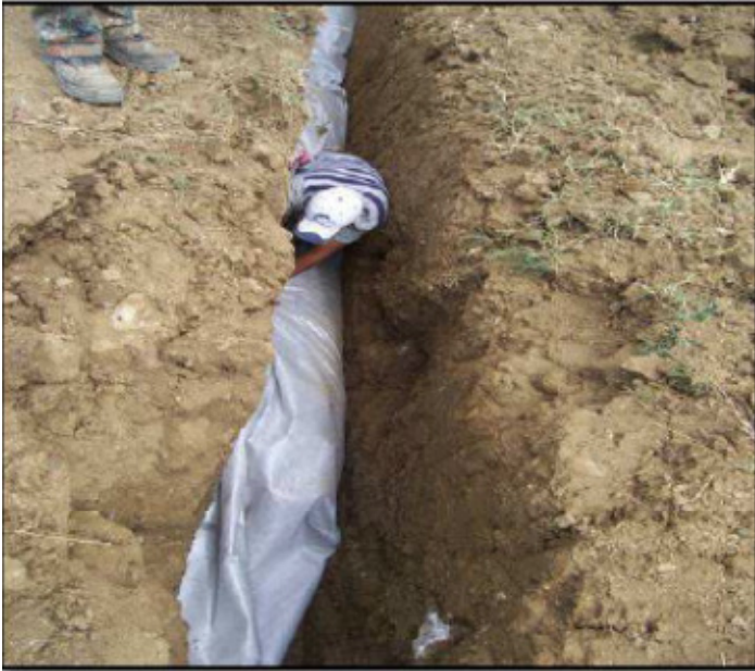
Figura 6 – Operazione di rivestimento dei sacchi drenanti col TNT effettuata manualmente all'interno della trincea
