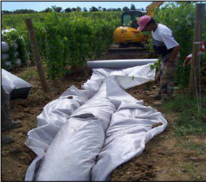
Figura 6 – Operazione di rivestimento dei sacchi drenanti col TNT effettuata manualmente all'interno della trincea
