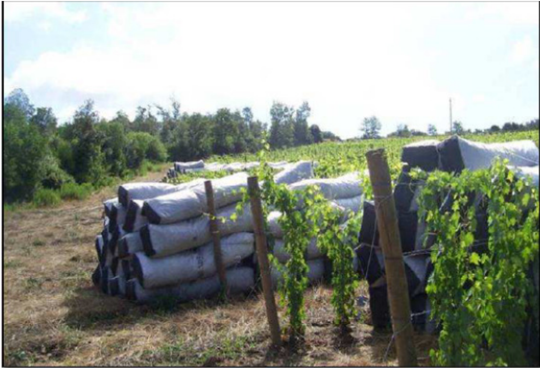
Figura 2 – Sacchi drenanti flessibili in non tessuto mod. IDROSAC 500 utilizzati
