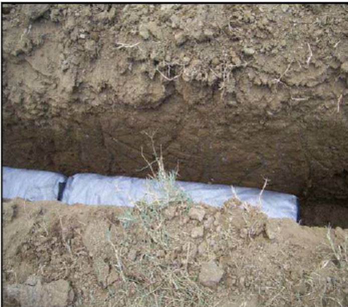
Figura 5 – Posizionamento dei sacchi drenanti IDROSAC 500 sul fondo della trincea
