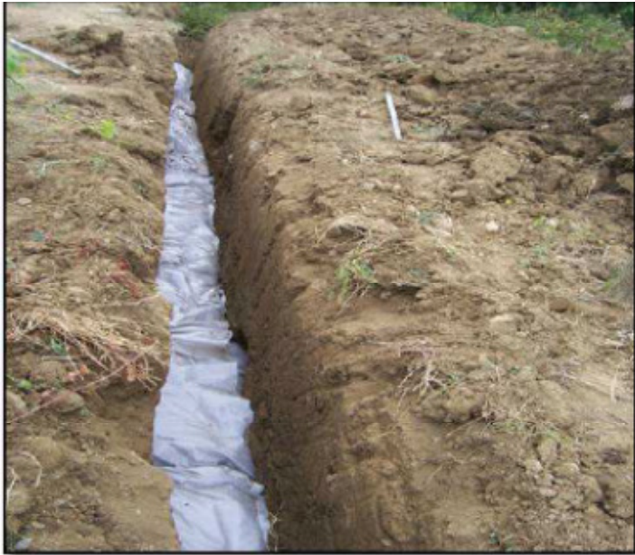
Figura 8 – Chiusura manuale del TNT sopra il sacco drenante IDROSAC 500
