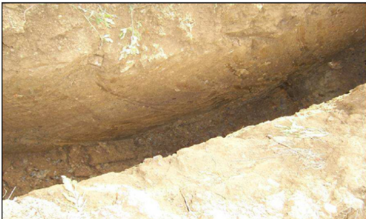
Figura 3 – Scavo effettuato con escavatore meccanico per la posa in opera del sistema IDROSAC 500 presso la tenuta di Montalcino (SI).
