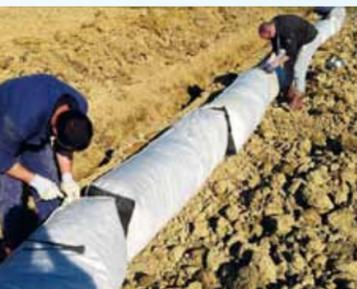
si esegue la giunzione dei moduli tra di loro, fuori dallo scavo, unendo con del filo di ferro le testate in rete scura tra di loro per dare continuità idraulica al sistema
