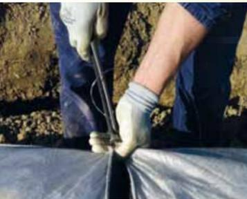
tra un modulo e l'altro si deve posizionare una fascetta di geotessile, fornita in dotazione, che impedisce la intrusione del terreno tra i prodotti, una volta legati si ottiene un lungo tubolare, leggero e pratico da posare nello scavo
