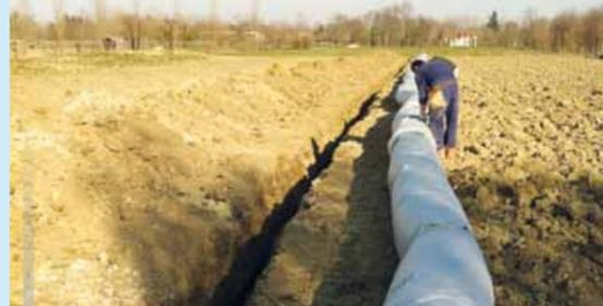
una volta posati tutti i prodotti in opera, si esegue il rinterro con terreno di scavo, che dovrà coprire il modulo con uno strato di terreno di circa 30-50 cm.
