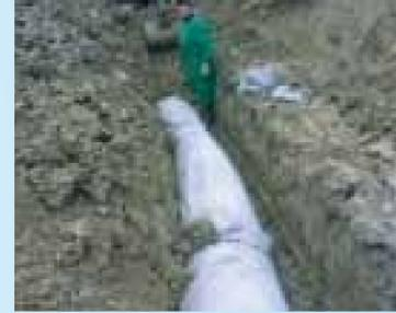
Après avoir posé tous les produits, exécuter le remblayage avec la terre d'excavation, qui devra recouvrir le module avec une couche de terre d'environ 30-50 cm.
