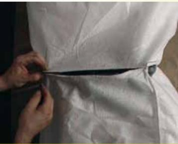
Entre un module et l'autre, positionner une bande de géotextile, fournie avec le système, afin d'empêcher la pénétration de la terre entre les produits. Après avoir liés les produits ensemble, l'on obtient un long rouleau, léger et pratique à poser dans la tranchée
