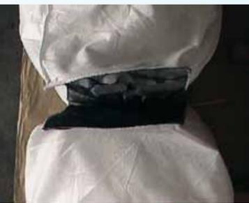
Exécuter l'assemblage des modules, à l'extérieur de la tranchée, en unissant avec du fil de fer les extrémités en treillis foncé entre elles pour garantir la continuité hydraulique du système.
