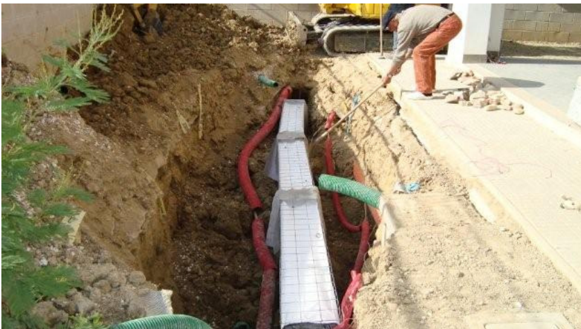
FIG. 4 finale de l'installation de panneaux de drainage
