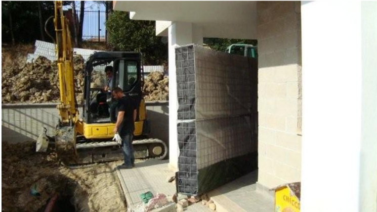
FIG. 3 panneaux drainant assembles prêt à être placé à l'intérieur des tranchées
