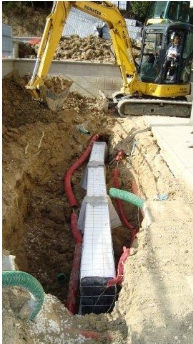
Le remplissage de la tranchée avec la terre excavée
