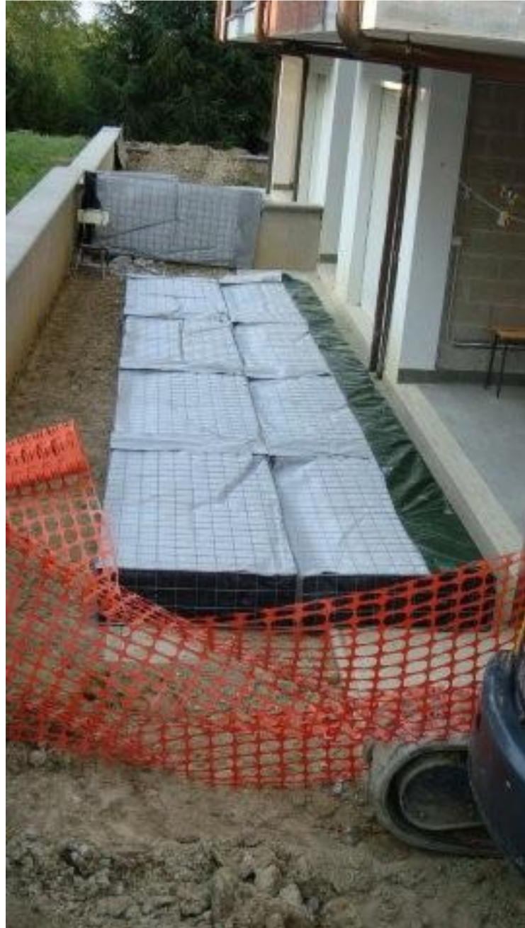
FIG 2 reliure de vidange PANNEAU et fixation des géomembrane au fond
