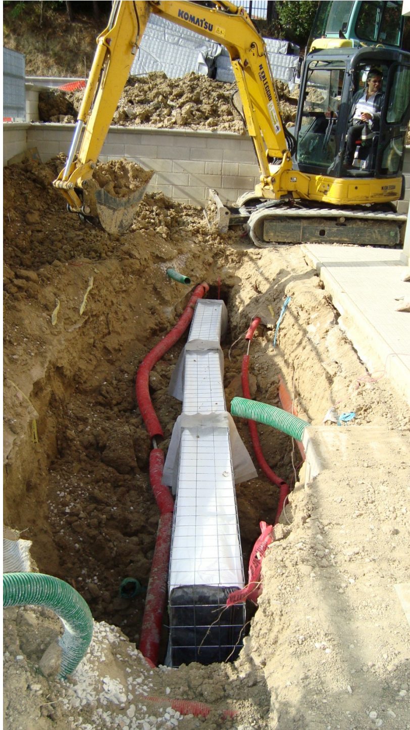
Phase du remplissage par excavateur.
