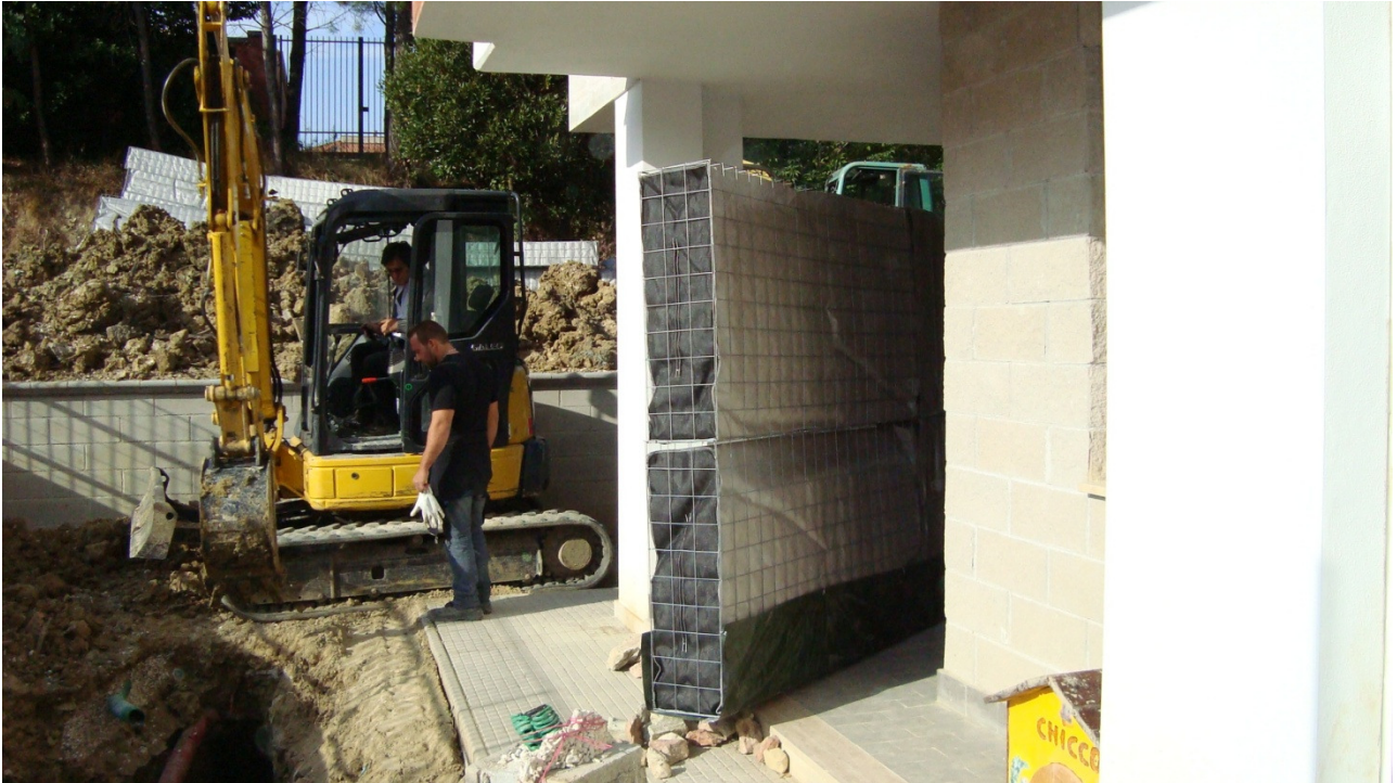
Modules DRENTER avant de la pose dans une tranchée fine.
