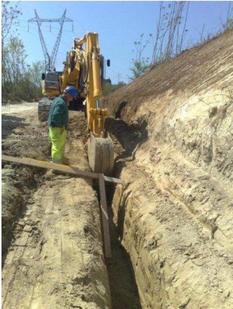
Figure 2-Excavation effectuée par excavateur mécanique pour la pose du system DRENTER.
