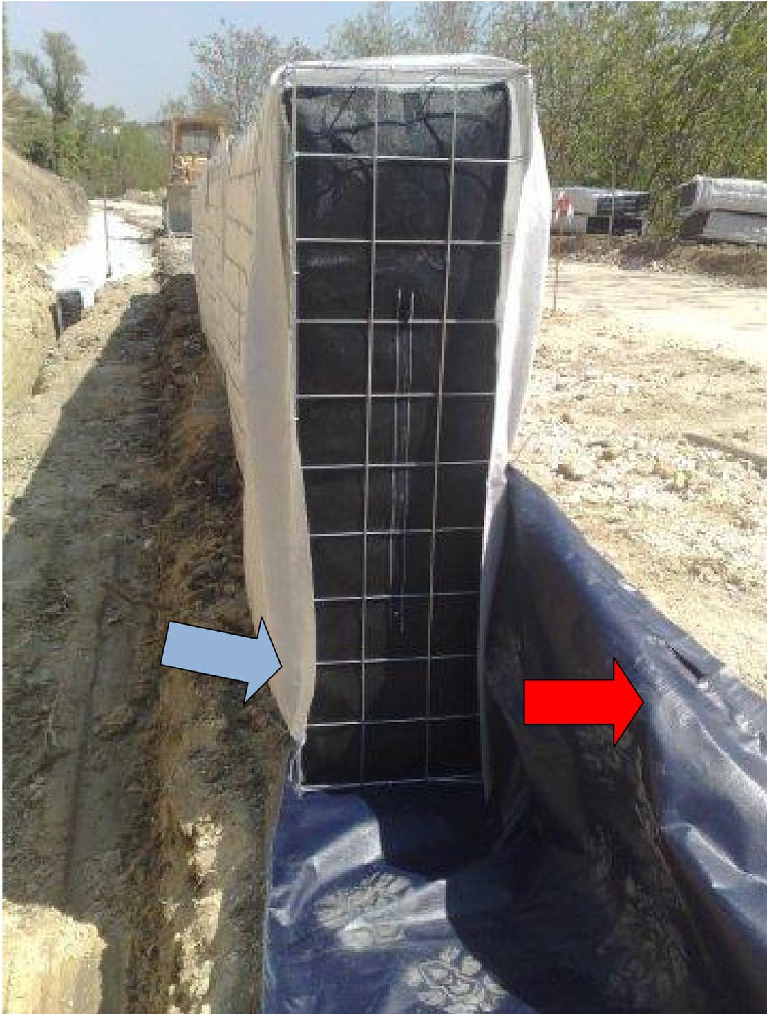
Figure 3-Pose de la gaine, positionnée à L, et aussi des panneaux dans la tranchée pour le drainage. Flèche bleu : partie rebaisse pour une meilleure captation des eaux; flèche rouge: partie relevé pour un effet barrière d'isolation.
