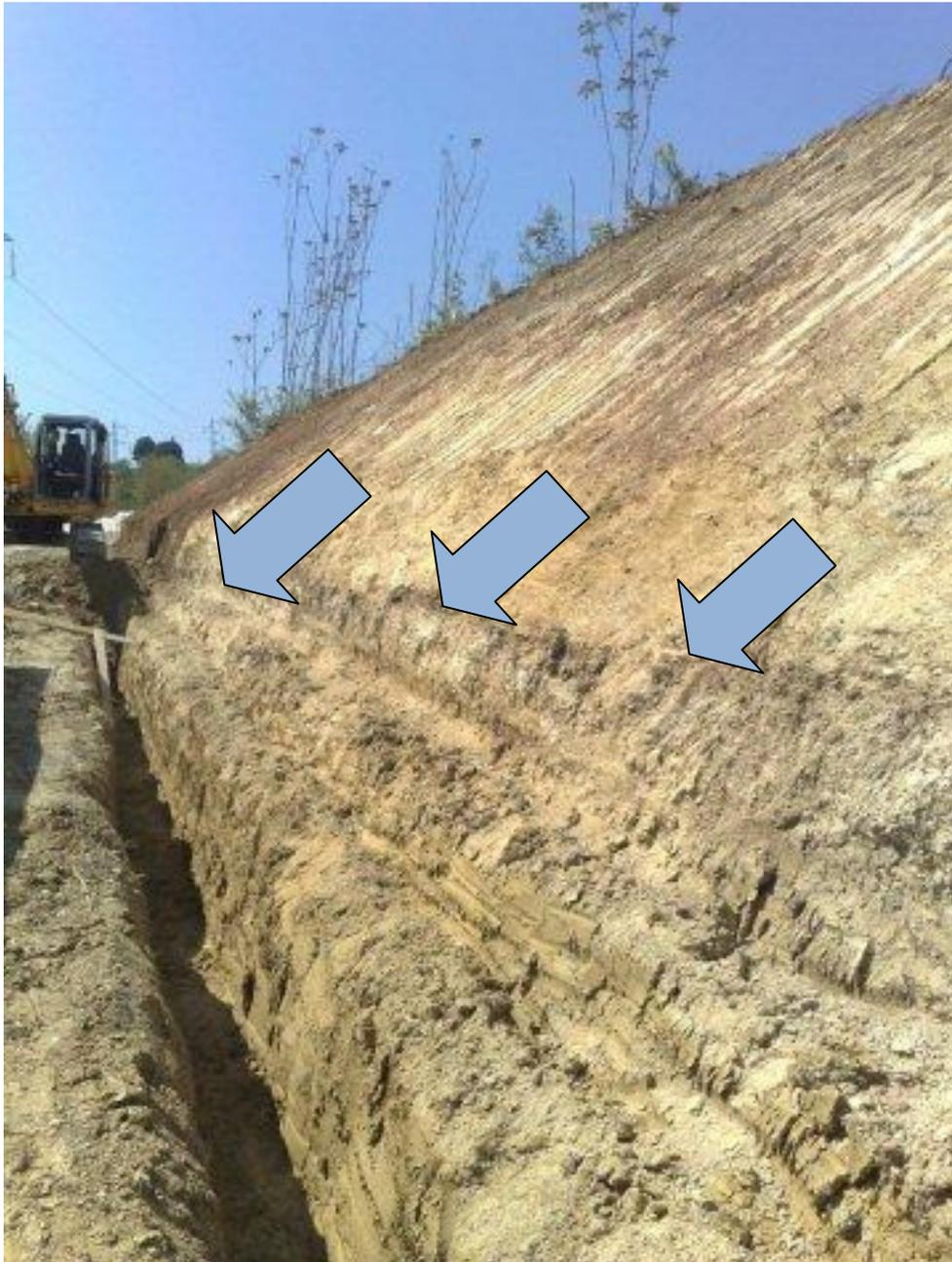
Le system DRENOTER<sup>®</sup> a été demandé pour la réalisation d'un system de drainage dans une fosse profonde en tranchée, au fin d'éloigner l'eau en excès, qui peut s'infiltrer dedans de la chaussée, en créant instabilité.
