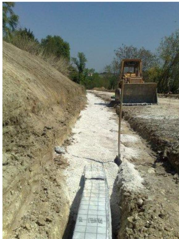
Figure.5 Pose en tranchée et remplissage de la fosse.
