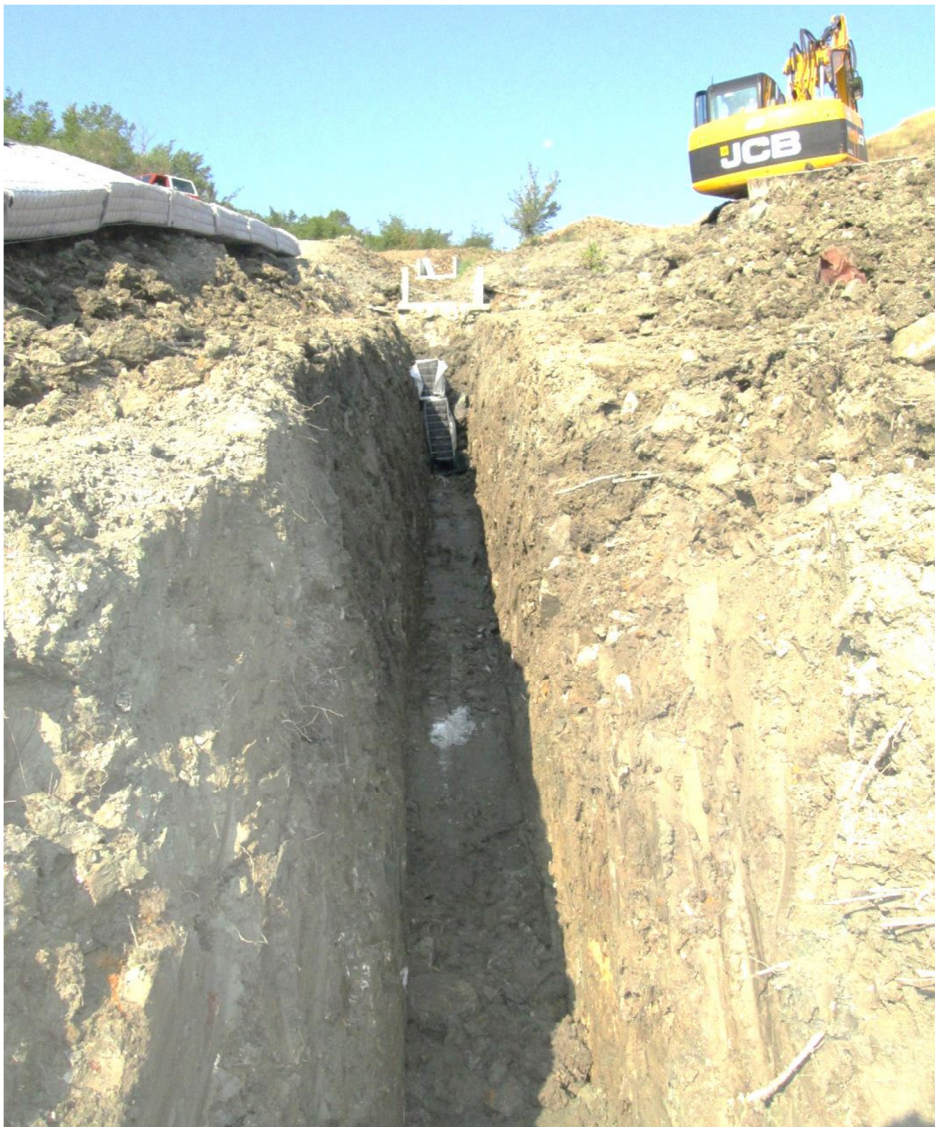
Figure 1. Tranchée obtenue par l'excavatrice, légèrement plus grande que le système de drainage
