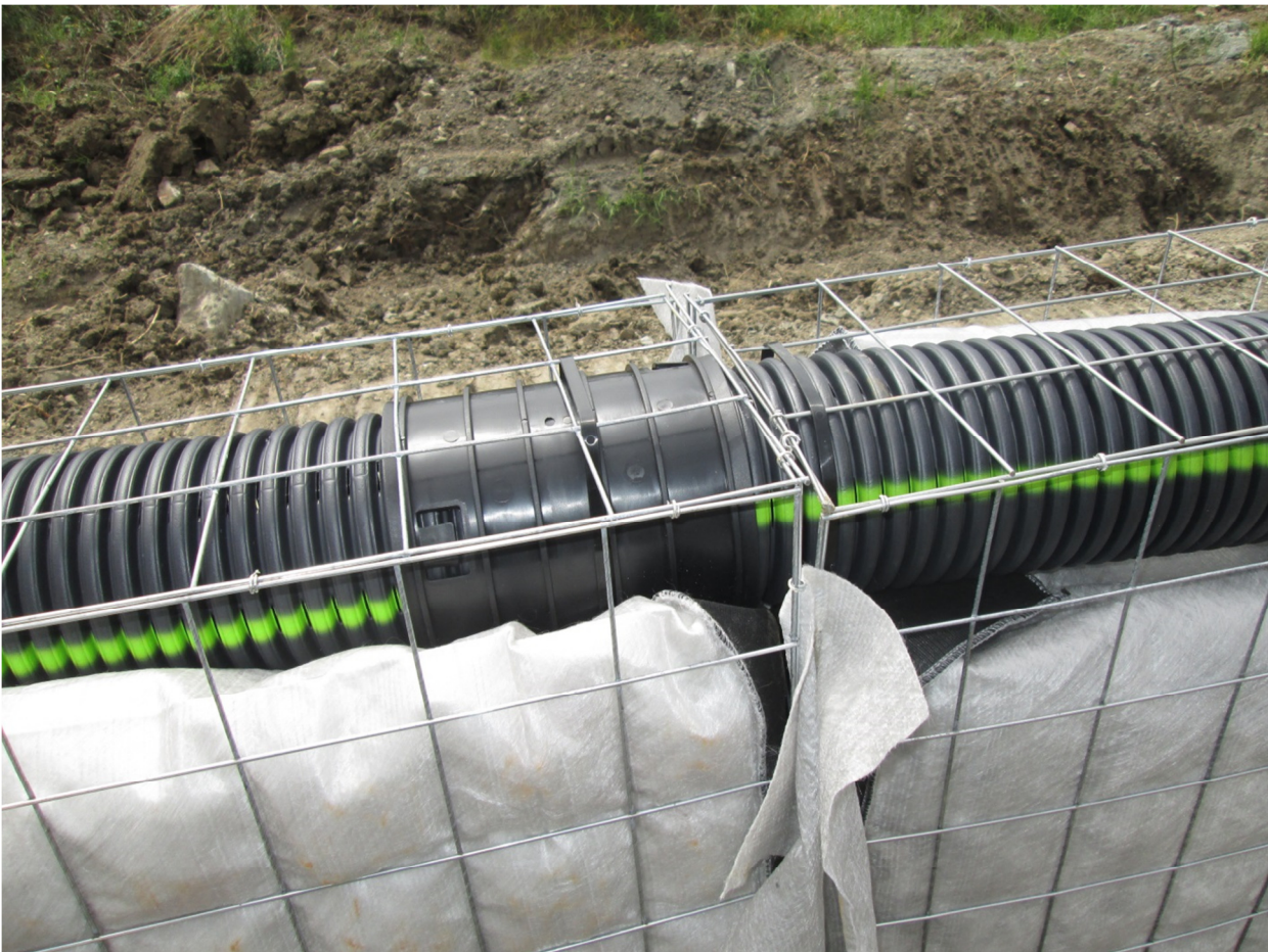
Figure 2. Panneaux DRYOTER PIPE reliés par un manchon pour garantir une étanchéité hydraulique parfaite
