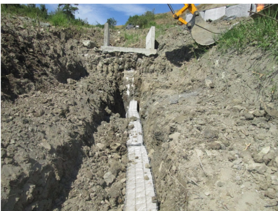
Figure 3. Vue d'ensemble du système de drainage stabilisé dans le sous-sol, avant d'être complètement recouvert
