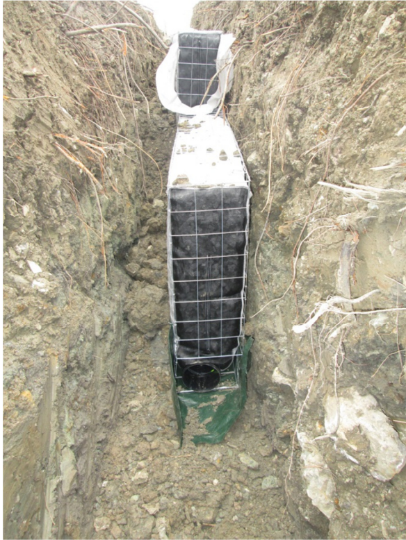
Figure 4. Vue d'ensemble du système de drainage, Figure 5. Système de drainage descendu dans la tranchée DRENTER PIPE et DRENTER 500 correctement raccordés
