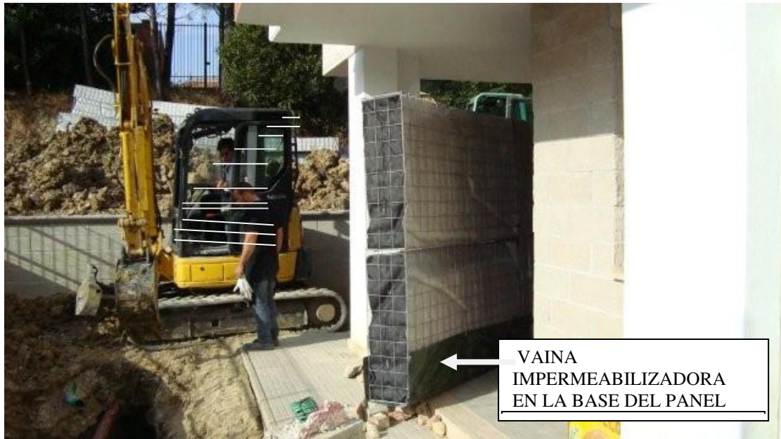
Dib.6 avance excavación trinchera
